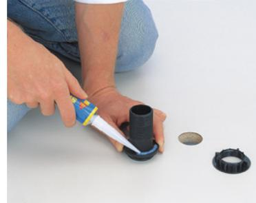
2. DEKAsyl MS-Kraftkleber auf den Stutzen der Dachdurchführung auftragen. Stutzen in die Bohrung einführen und von unten mit der Rändelmutter fixieren.
