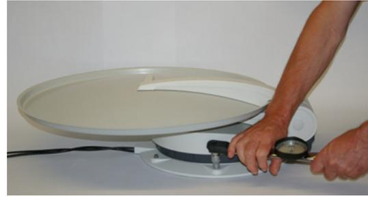
9. Dreheinheit mit einem Drehmoment-Schlüssel wieder auf die Montageplatte schrauben.
